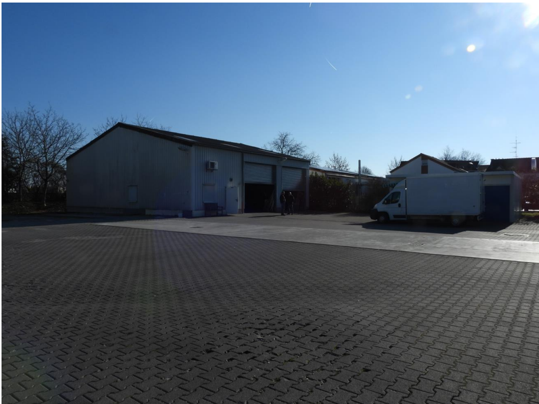
Bild 08: Gesamtansicht Lagerhalle und Hof
