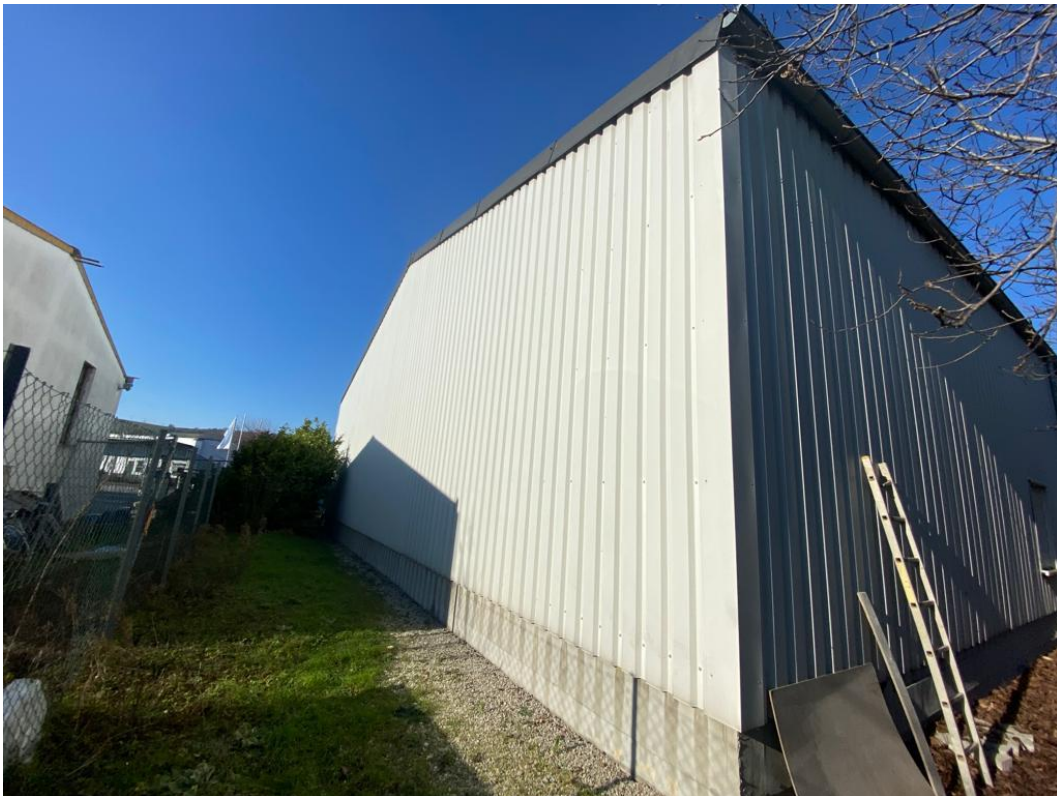
Bild 02: Die Südansicht der Lagerhalle
