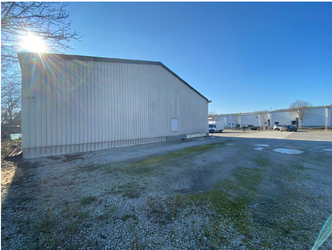
Bild 04: Blick auf die Nordseite der Lagerhalle
