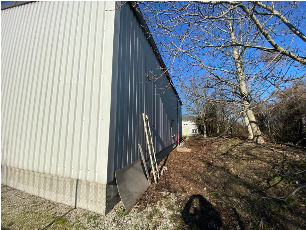
Bild 03: Die östliche Seite der Lagerhalle
