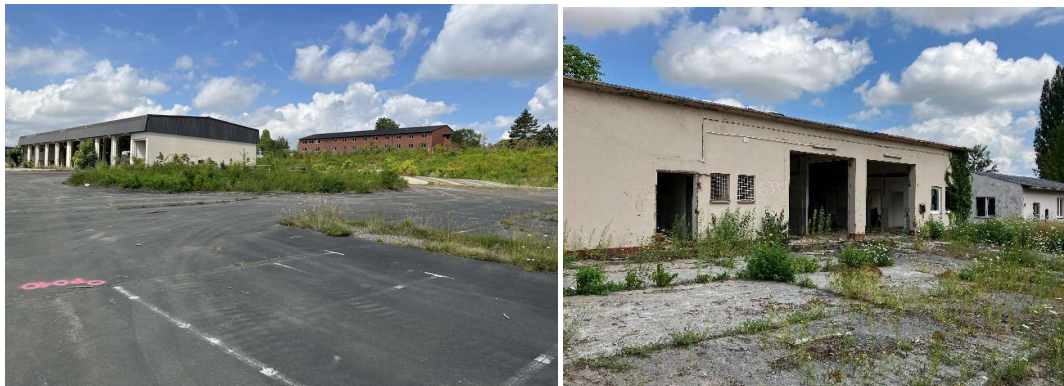
Abbildung 6: Bestandsinfrastruktur, -oberflächen und -gebäude (2) (Quelle: Eigenes Foto)
