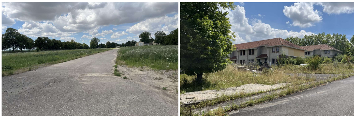
Abbildung 4: Bestandsinfrastruktur und -gebäude (1) (Quelle: Eigenes Foto)
